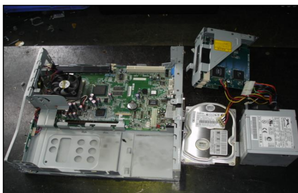
③部品をそれぞれ取り外し、素材ごとへ解体
